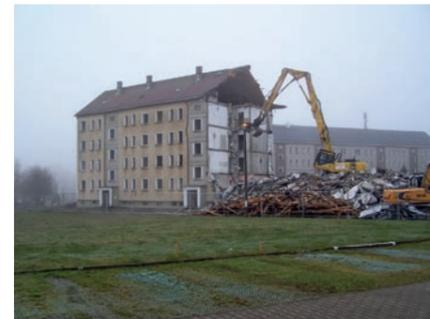
Abbruch mittels Long-Front-Bagger
