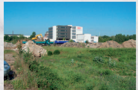
Entsorgung des Abbruchmaterials
