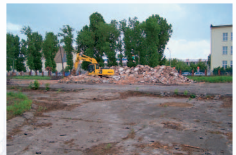
Abbruchmaterial ehem. Kfz-Waschanlage
